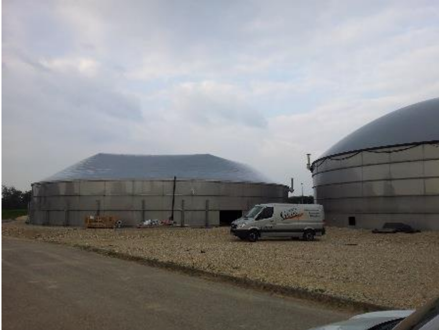
Dach beim Aufblasen.
