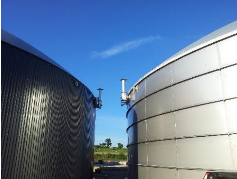
Fermenter und Endlager im Bau.
